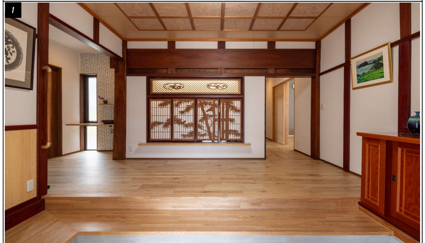
▲既存和室①③の床を基準に、家全体の段差をなくして安全に出入りができるように。通路幅も広くなり、安心して行き来ができるようになった。
