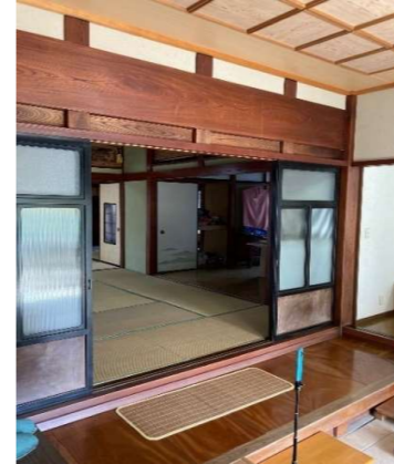
ホール①の幅が狭く、段差も多くて危ない。 玄関～ホール①段差:210mm ホール①～和室②段差:110mm
