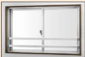
転落防止の手すりの設置
